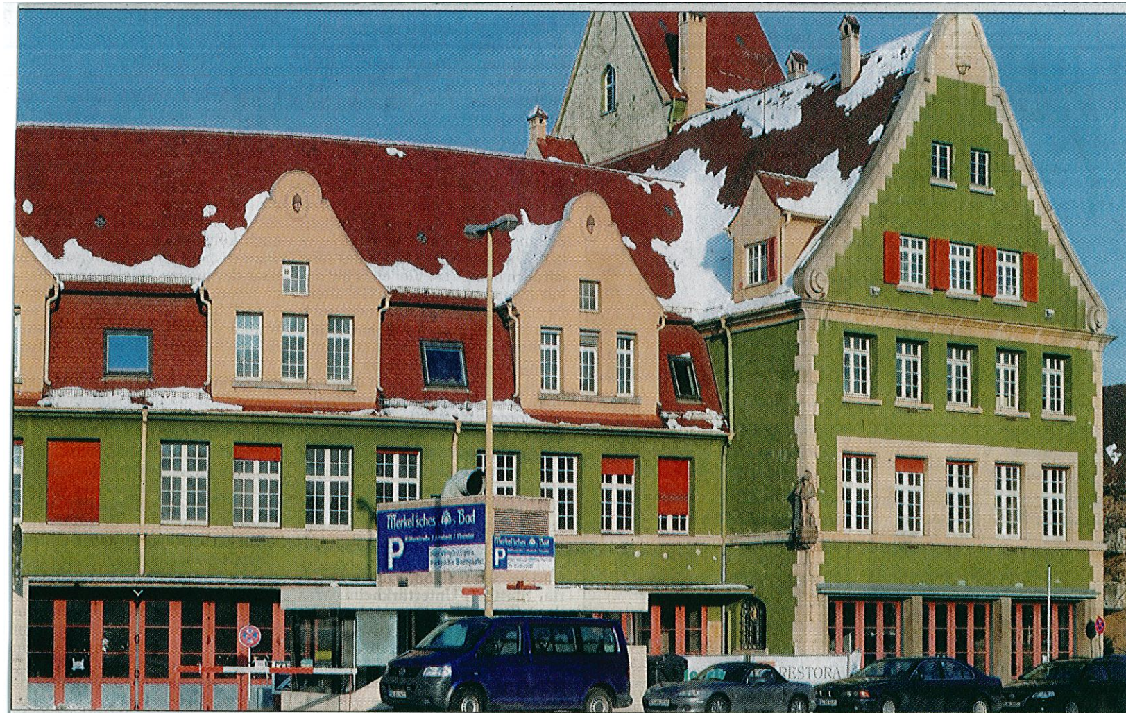
Warten auf den Startschuss: In der alten Feuerwache beginnen in Kürze die Bauarbeiten. Im rechten Teil des Untergeschosses wird Ende des Jahres die Eselsmühle einziehen. Die angrenzende Fläche übernimmt Naturgut. Der Pavillon auf dem Vorplatz erreicht die Höhe des Zugangs in die Tiefgarage. Foto: Kaier
